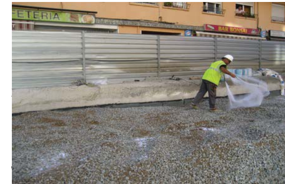
Moment del inici de l'aplicació de l'hidrogel
