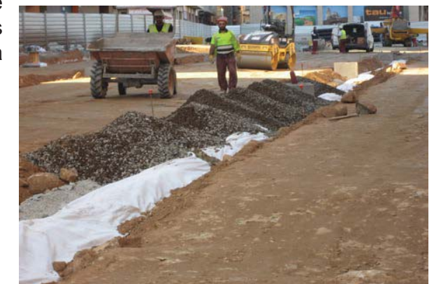
Distribució i reblert sòl estructural
