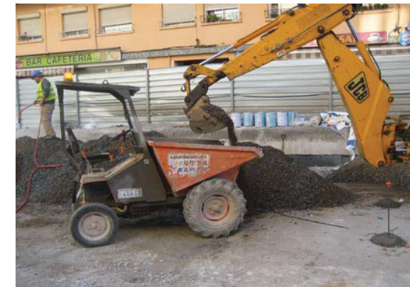
Carrega de sòl estructural en bolquet
