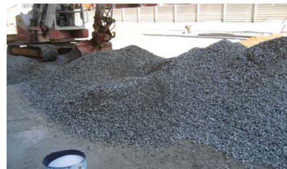
Estesa material barrejat per la incorporació de l'hidrogel i l'aigua
