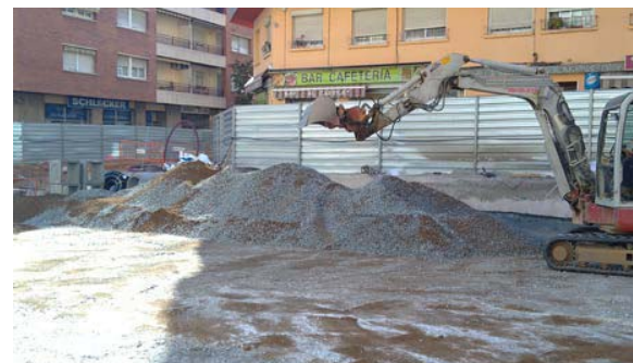
Estesa material barrejat per la incorporació de l'hidrogel i l'aigua
