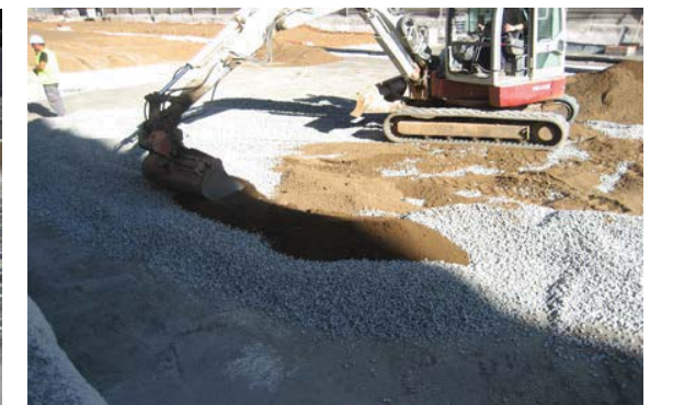
Incorporació de terra vegetal
