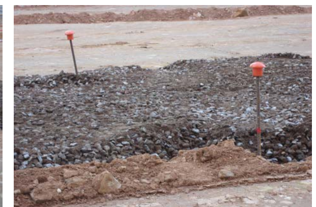
Nivell de reblert i estesa
