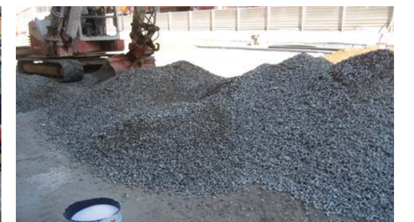
Estesa material barrejat per la incorporació de l'hidrogel i l'aigua
