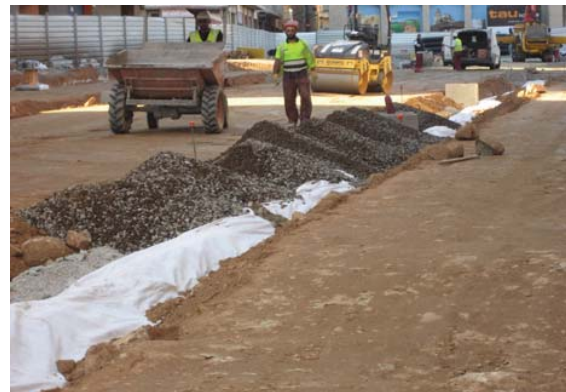
Distribució i reblert sòl estructural
