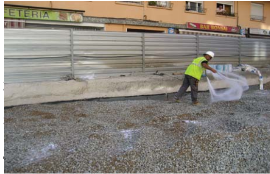
Moment del inici de l'aplicació de l'hidrogel
