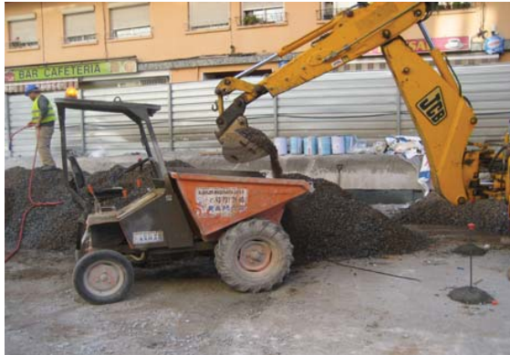
Carrega de sòl estructural en bolquet
