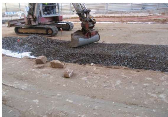
Estesa del sòl estructural
