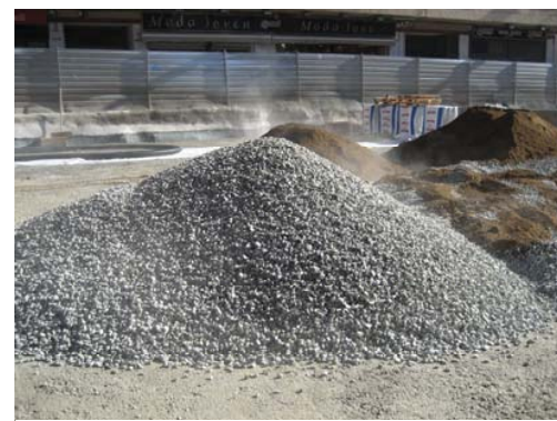
Aplec de grava de pedrera
