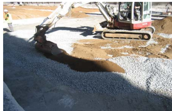
Incorporació de terra vegetal
