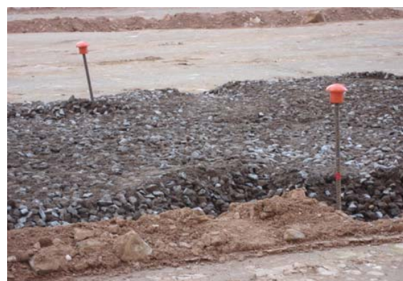
Nivell de reblert i estesa
