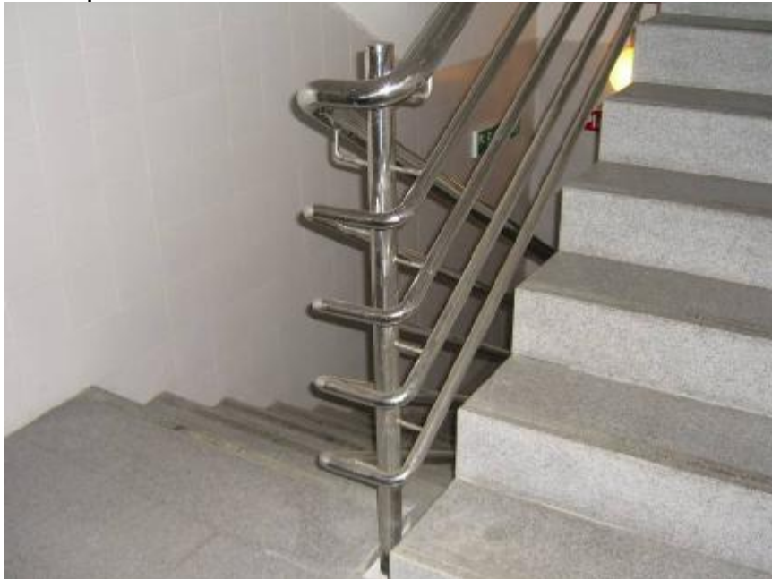
Barana interior i paviment en accessos vianants:
