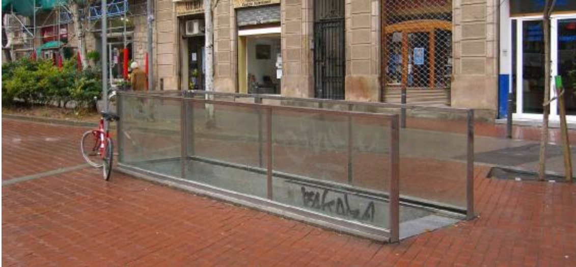
Barana exterior accessos:
